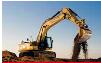
ERD-, TIEF-, STRASSENBAU
